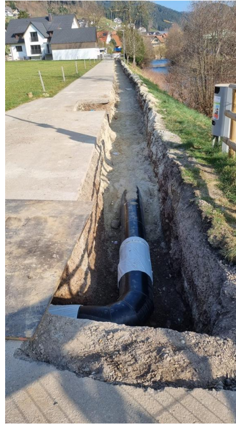
Verlegung KMR-Doppelrohr
