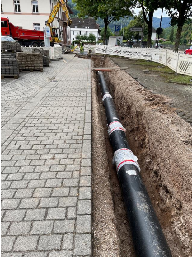
Verlegung KMR-Doppelrohr
