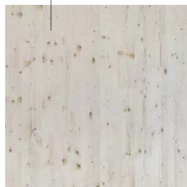
Wand Brettsper Holz sicht
