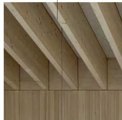
Tragkonstruktion Balkendecke Sicht
